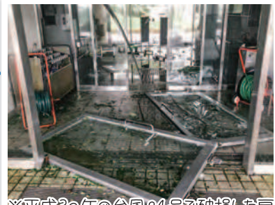
※平成30年の台風24号で破損した扉
