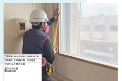
撤去前の飛散防止対策状況（養生）
