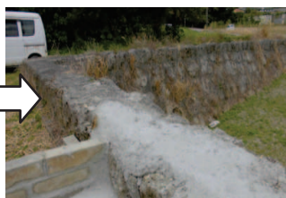
▲作業後の石積の様子
