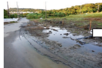
▲側溝の土砂上げ作業（与座）
