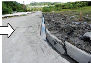
▲土砂上げ作業後の状況写真
