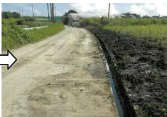
▲大雨時流出した土砂除去作業後の様子
