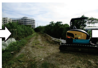
▲重機を使用しての伐開の様子
