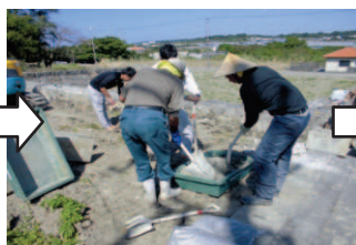
▲使用する材料の攪拌作業
