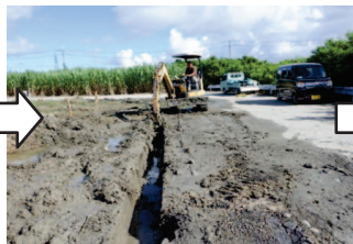
▲重機を使用しての土砂上げの様子
