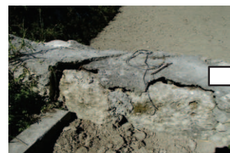
▲石積補修・補強作業（山城）
