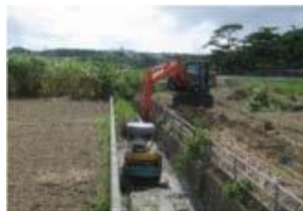
水路の土砂上げ作業
