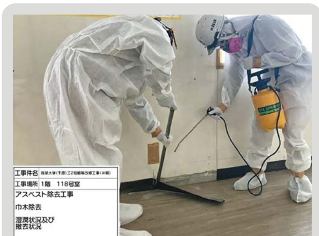
アスベスト含有材の湿潤および撤去状況
