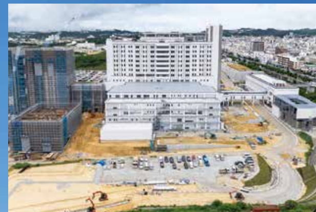
病院西側写真（2024 年 6 月撮影）
