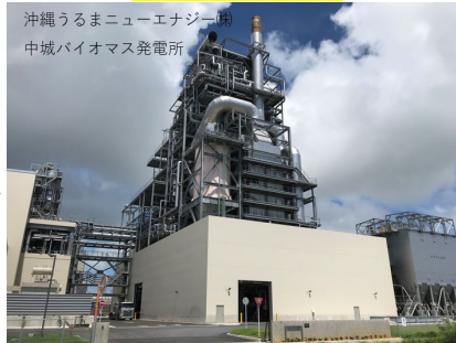
バイオマス発電所(うるま市)
