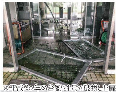
※平成30年の台風24号で破損した扉
