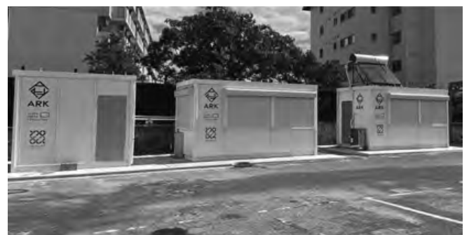
図15 農水一体型循環システム構築に向けて魚類+藻類複合養殖の実証試験を行うためにキャンパスに設置された小型閉鎖循環式システム組み込みコンテナ
