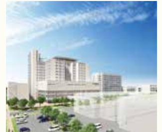
上図:完成イメージ ※今後の進捗により変更になる可能性があります。
