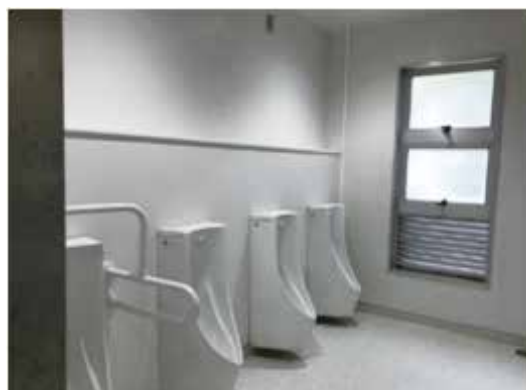
(千原) 分子生命科学研究所施設2号館他トイレ改修工事 [第2体育館 男子トイレ]
