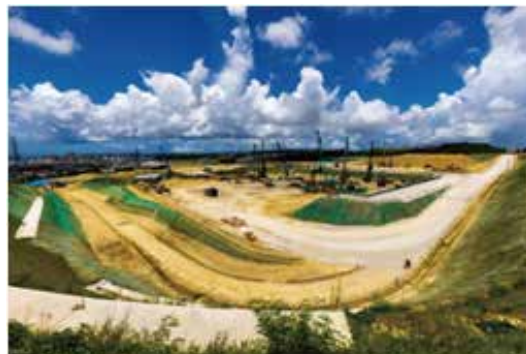
(西普天間) 病院新営その他工事 R03年度7月時点
