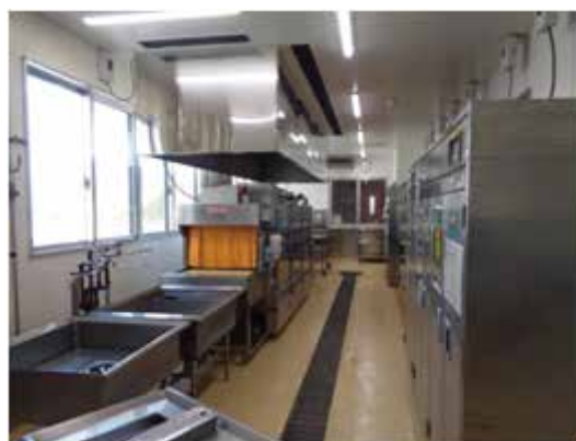
(千原) 附属学校給食棟新営その他工事 [給食棟 建物内観]
