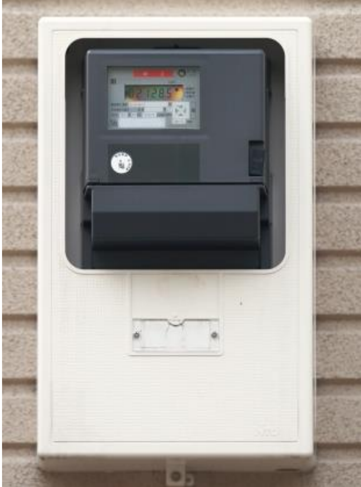
スマートメーター
