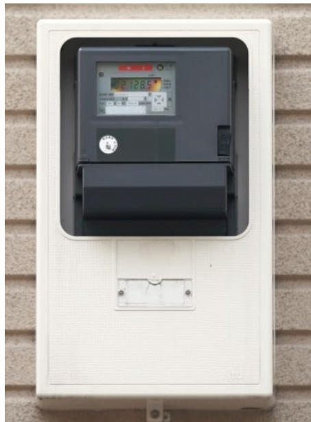
スマートメーター
