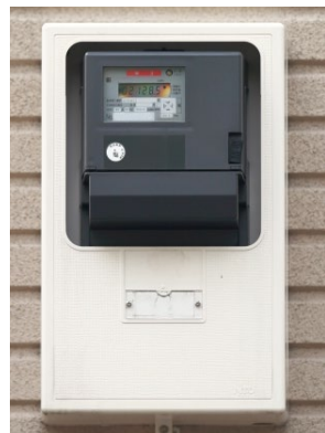
スマートメーター
