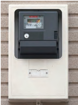
スマートメーター
