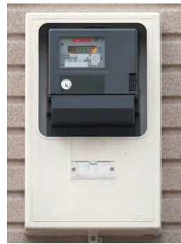
スマートメーター
