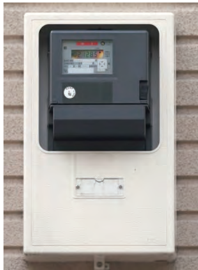
スマートメーター
