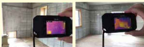
図2 琉大 ZEH 実証実験棟の南側面（写真上）。東側（写真右）が従来工法、西側（写真左）が断熱工法で建築されており、サーモグラフィーカメラを見ると蓄熱具合に明確な差がある。
