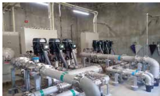
(千原) ライフライン再生(給水設備) [設備機械棟 ポンプ新設]
