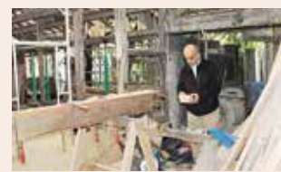
▲木造修復現場
