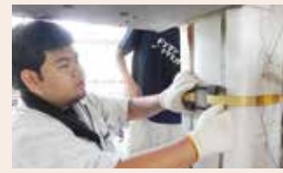
▲損傷柱の補強
