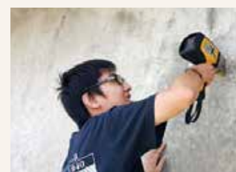
▲コンクリート構造物の調査
