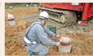
▲基礎杭の調査
