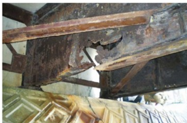
写真1 沖縄において激しく腐食劣化した鋼橋
