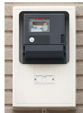
スマートメーター
