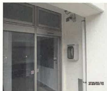
新棟女子寮玄関 防犯カメラ（右上部）
