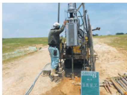
(西普天間) 基幹・環境整備 (地盤調査等)
