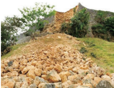
地震によって崩れた勝連城壁
