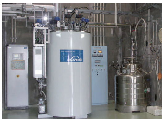
ヘリウム液化・供給システム
