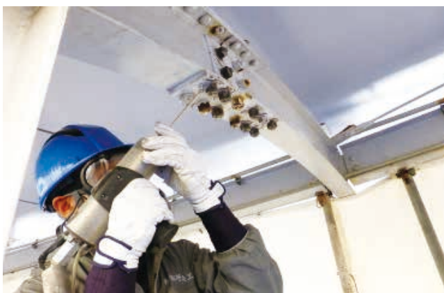
CS 試験施工とモニタリング
