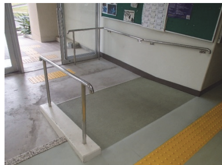
図2 共通教育棟3号館1階出入口スロープ
