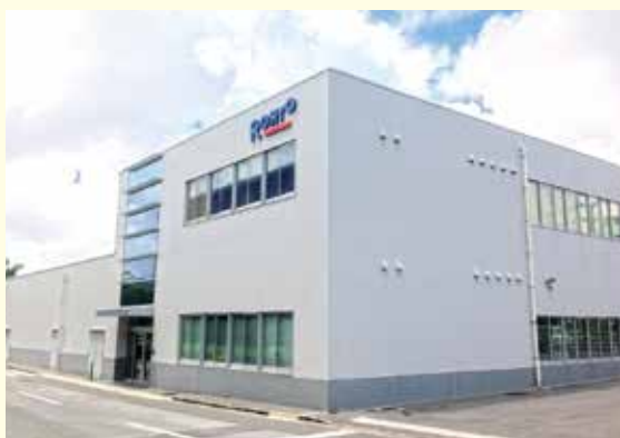
▲再生医療研究センター外観
