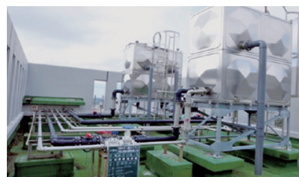
(千原) ライフライン再生(高置水槽等改修) 工事
