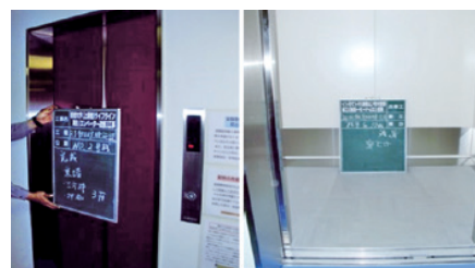
(上原他) ライフライン再生(エレベーター改修) 工事
