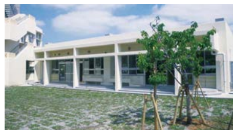
琉球大学(附小)附属小学校校舎新営工事等
