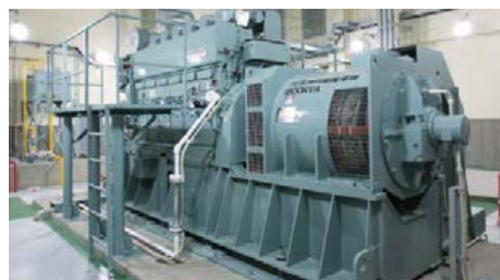
琉球大学(医病)自家発電設備棟新営その他工事等
