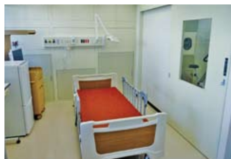
○附属病院棟9階無菌室改修
