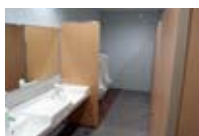
附属図書館トイレ改修
