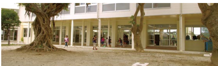
附属小学校校舎等改修
