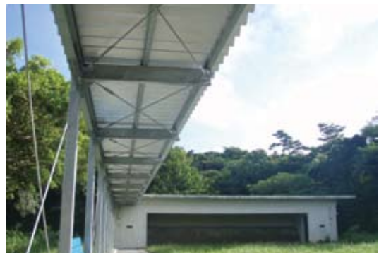
弓道場改修(屋外通路上屋設置)
