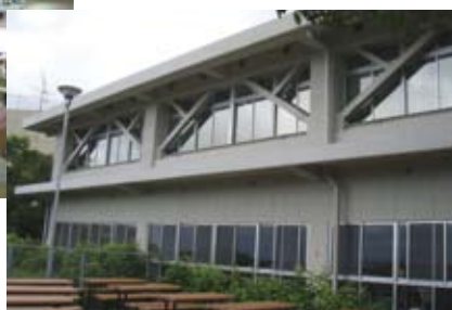
中央食堂耐震改修
