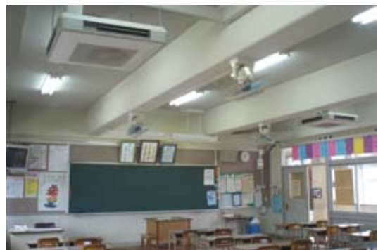
附属中学校空調改修
